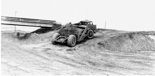
Рис. 30. Въезд скрепера на насыпь по съезду.
