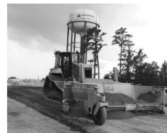
Укладка щебня щебнеукладчиком R600С.
