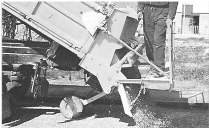
Рис. 69. Распределение расклинивающей фракции с использованием щебнераспределителя.
