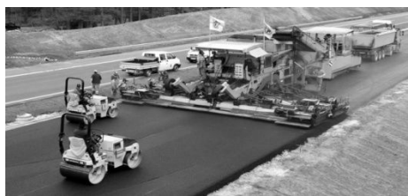
Рис. 73. Укладка асфальтобетонного покрытия а) одним асфальтоукладчиком б) двумя или тремя асфальтоукладчиками.
