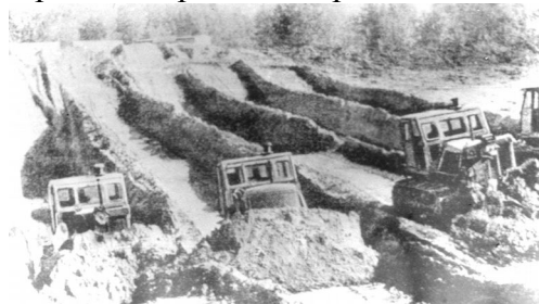
Рис. 19. Послойно-траншейная разработка грунта бульдозерами.
