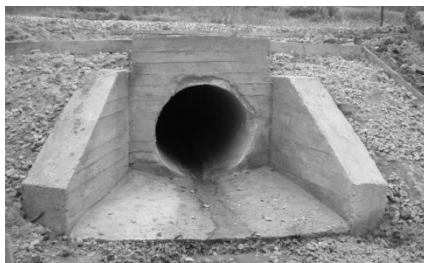
Рис. 5. Общий вид железобетонных труб с раструбным оголовком а) круглого сечения б) прямоугольного сечения.
