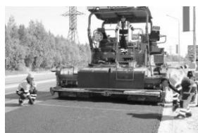
Контроль ширины покрытия
