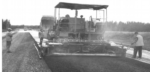
Рис. 71. Укладка чёрного щебня.
