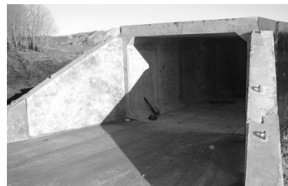
Рис. 5. Общий вид железобетонных труб с раструбным оголовком а) круглого сечения б) прямоугольного сечения.
