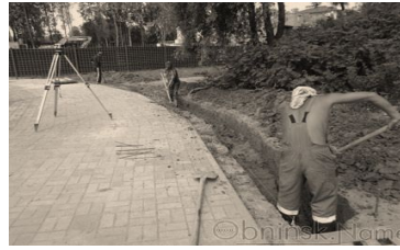
Рис. 8б. зачистка дна кювета по отметкам
