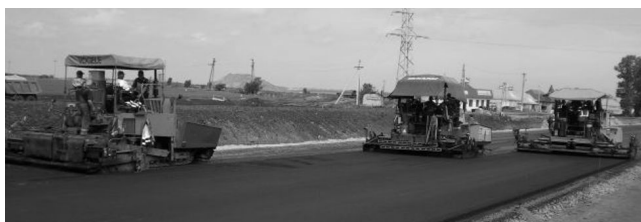
Рис. 73. Укладка асфальтобетонного покрытия а) одним асфальтоукладчиком б) двумя или тремя асфальтоукладчиками.
