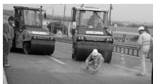
Контроль ровности покрытия
