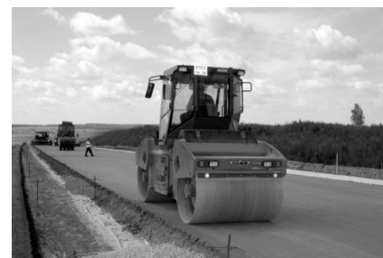
Уплотнение основания виброкатком.
