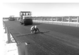
Контроль поперечных уклонов покрытия
