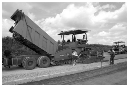
Распределение смеси распределителем
