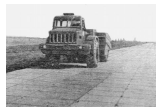
Осадка плит пневмокотком.
