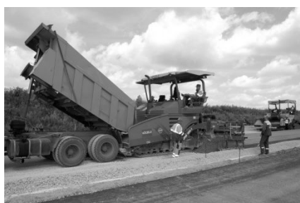
Распределение смеси распределителем
