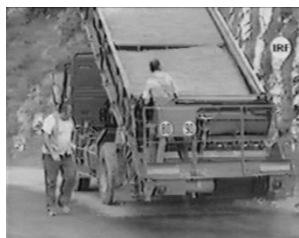
Распределение щебня навесным щебнераспределителем
