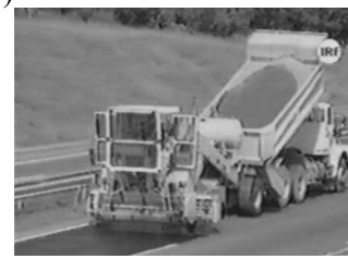
Устройство поверхностной обработки с применением Чипсиллера
