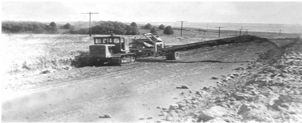
Рис. 31. Схема работы грейдер-элеватора
