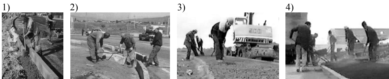
Рис. 95. Работы по строительству тротуаров:
