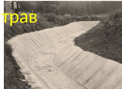
Рис. 9в Укрепление дна кювета бетонным полотном
