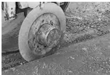
Рис. 72. Обрезка и обработка края ранее уложенной полосы.
