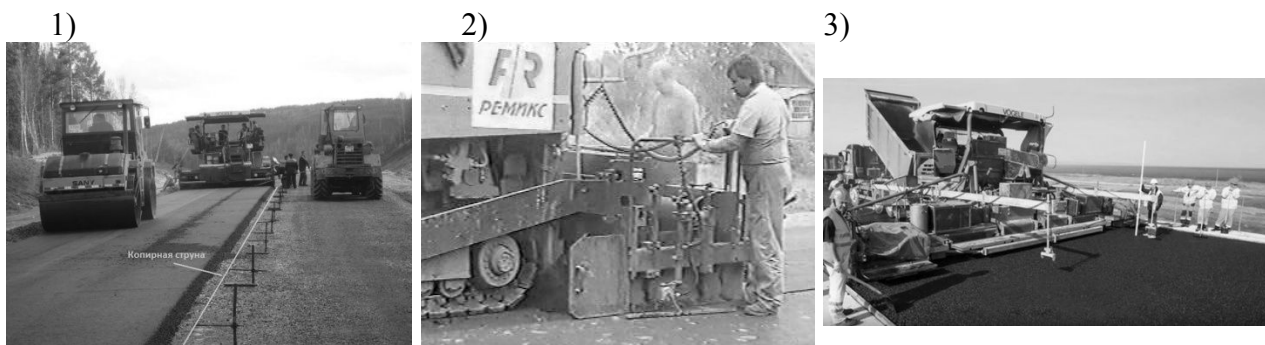
Рис. 75. Работу асфальтоукладчика в автоматическом режиме обеспечивают: 1) копирной струной; 2) поверхностью ранее уложенной полосы. 3) с использованием Систем Автоматического управления
