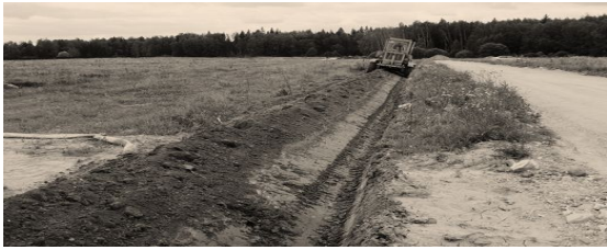
Рис. 8а. Нарезка кювета автогрейдером
