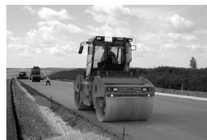
Уплотнение основания виброкатком.
