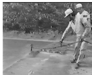
Рис. 72. Обрезка и обработка края ранее уложенной полосы.
