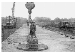
Осадка плит виброплитой.
