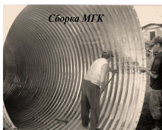
Сборка трубы из элементов
