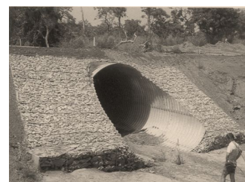
Укрепление откосов трубы
