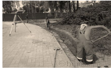
Рис. 8б. зачистка дна кювета по отметкам
