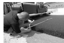
Контроль толщины покрытия
