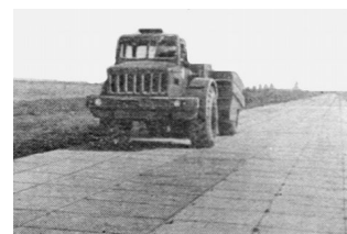
Осадка плит пневмокатком.
