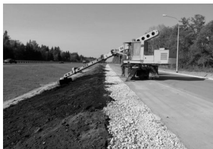
Рис. 44. Перемещение растительного грунта на откосы и обочины.
