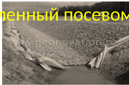
Рис. 9б Укрепление дна кювета матрасами Рено
