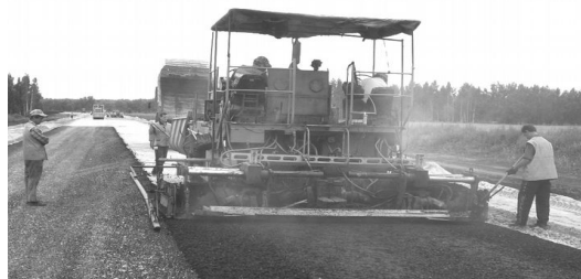
Рис. 71. Укладка чёрного щебня.
