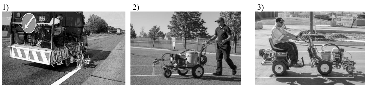
Рис. 101. Выполнение разметки краской разметочными машинами.
